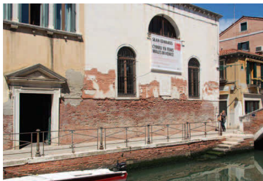
Eingang zum Pavillon Wales
